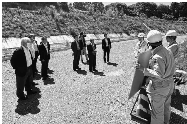
造成中の県道原海老津線視察
