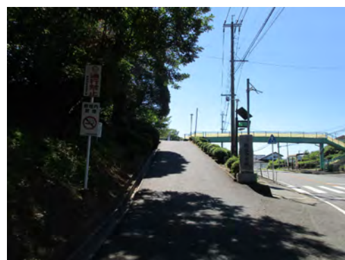
③⑦ 南西側出入口
