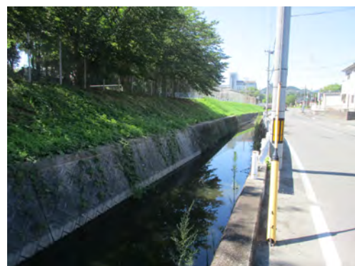
③② 西側水路
