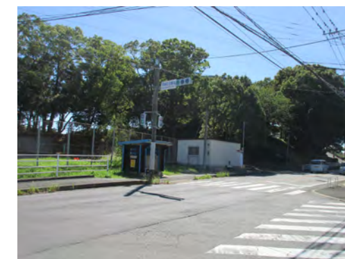
③⑤ 南西側出入口
