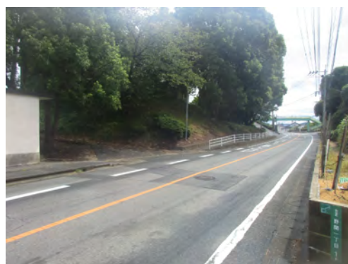
③⑥ 南西側出入口
