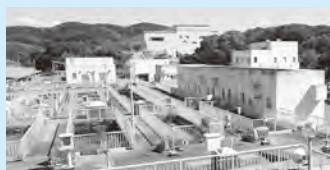
◀ 浄化センター
