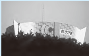
▲ 海老津配水池
