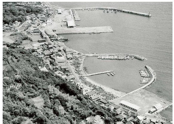
波津漁港に完成した防波堤／「ふるさと岡垣」
