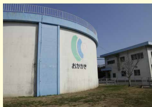
⑥岡垣町浄水場
