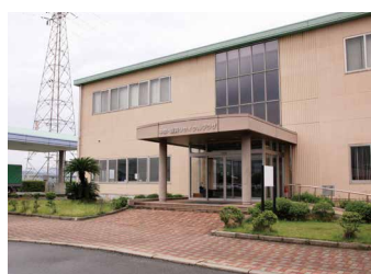
中間・遠賀リサイクルプラザ
