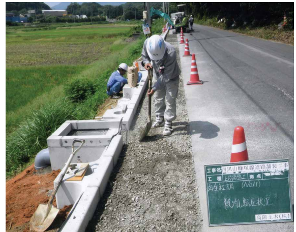
コンクリートなどの廃材を再利用して工事をする様子
