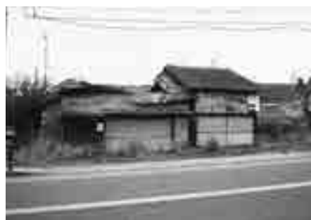
放置された危険家屋
