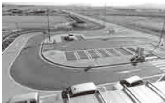
遠賀川駅南側駅前広場
