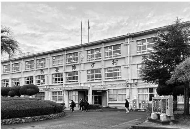
築62年の岡垣中学校校舎
