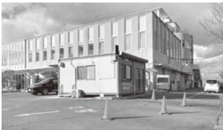
新しく設置されたPCR検査センター
