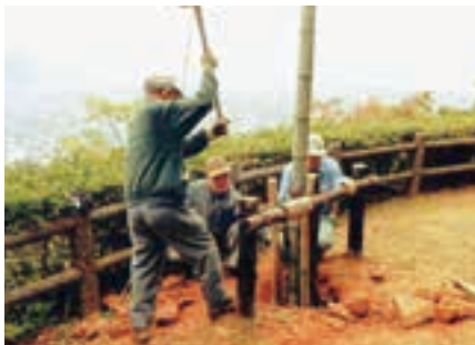
国旗掲揚台を改修
