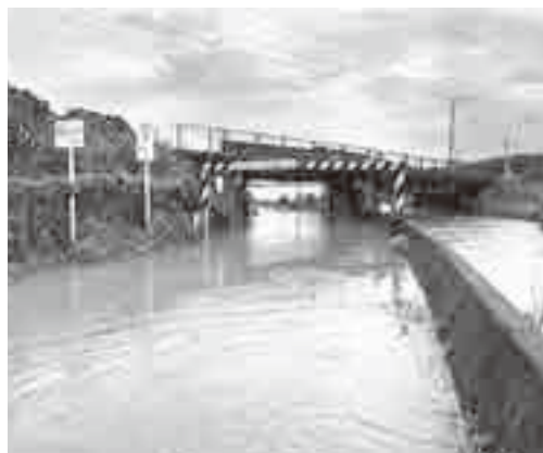
令和元年8月29日の戸切ガード下
