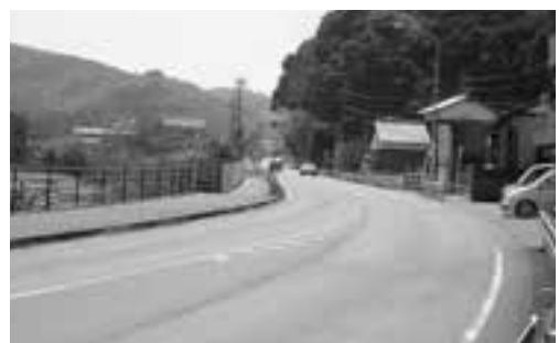
旧3号線 中村交差点付近
