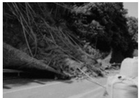
上畑・海老津線の災害現場
