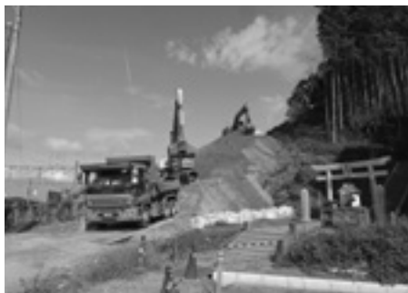
海老津駅南側開発工事
