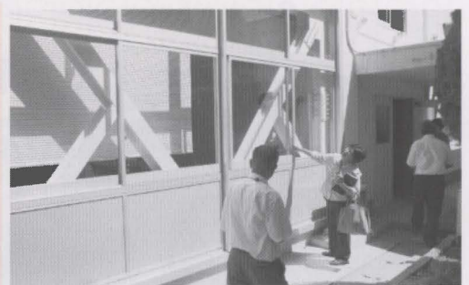
戸切小耐震化工事
