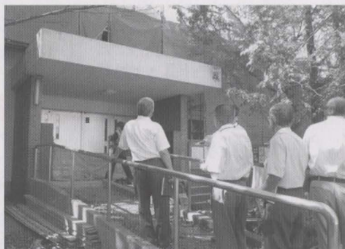
9/14 各小学校耐震化の視察(海老津小体育館工事)
