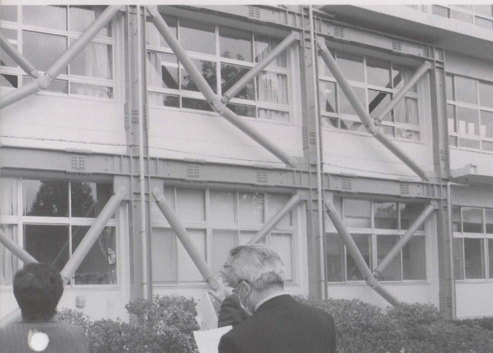
耐震化工事が完了した内浦小学校
