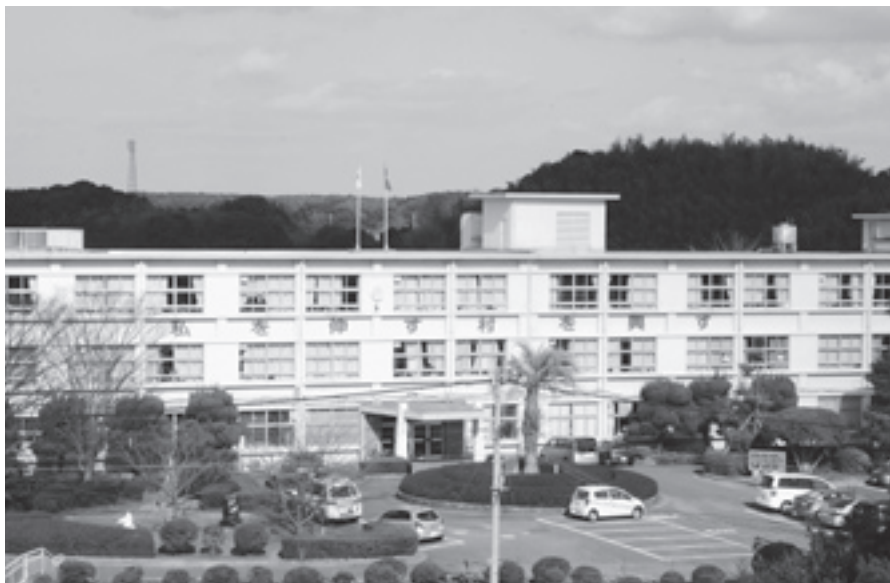
耐震化工事が決定した岡垣中学校
