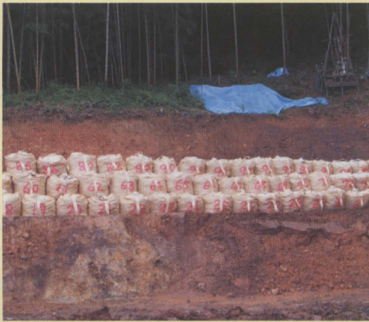
上戸切斜面崩落現場
