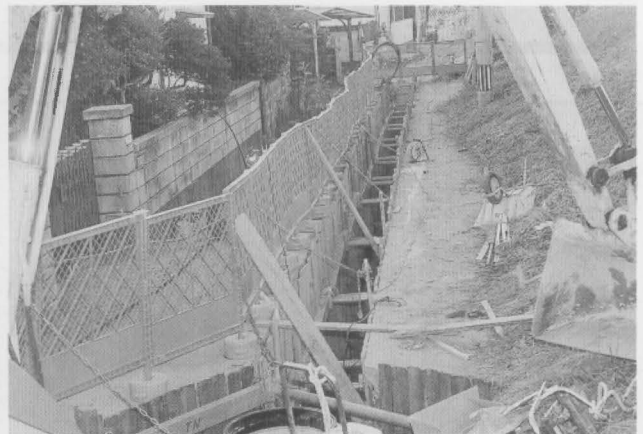
着々と進む下水道工事
