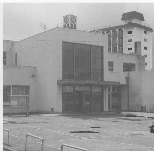
冷暖房集中管理システム工事を完了した東部公民館
