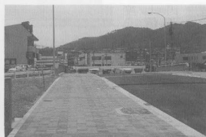
都市計画道路赤井手源十郎線の橋梁取付部分の歩道
