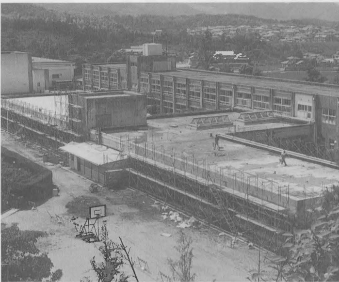
改造工事が進む海老津小の南平屋校舎
