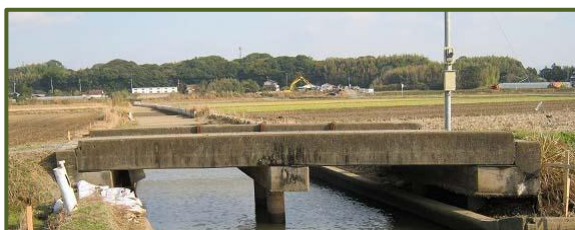
千手寺田1号橋（架設年不明）
