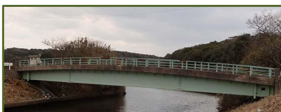
汐入川橋（1977年架設）
