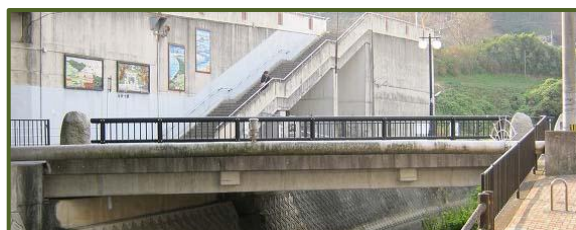
第二白谷橋（1994年架設）
