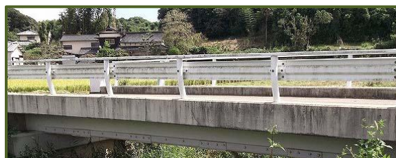
岸元橋（架設年不明）
