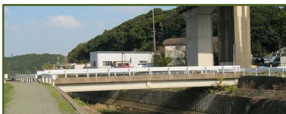
鍋田一号橋（1992年架設）
