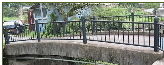
立田橋（1994年架設）
