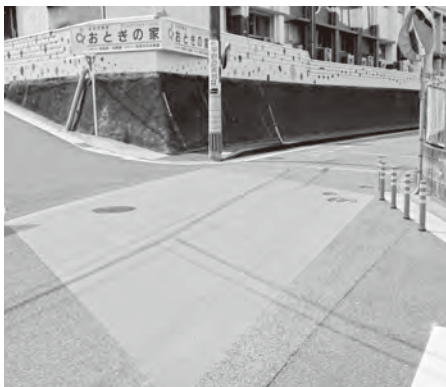
▲カーブミラーなどの設置、カラー舗装後の様子
