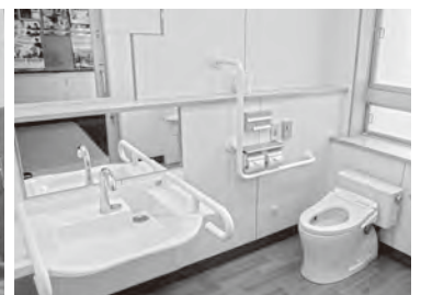
▲岡垣東中学校多目的トイレ
