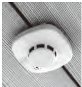
◀火災警報器の例
