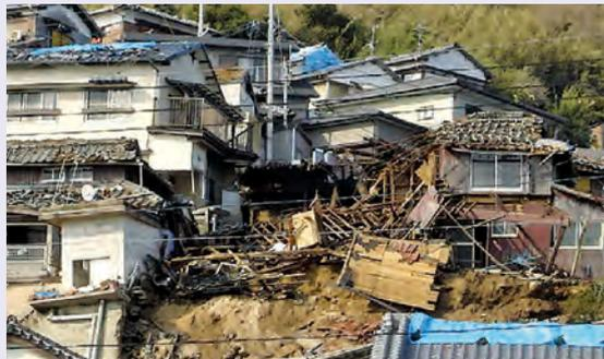
悲しみをもたらしました。記憶に新しい28年には震度7を記録した熊本地震が発生。崩壊した熊本城の天守閣などの被害状況を目にした人も多いのではないのでしょうか。(写真：県砂防課ホームページより玄界島の急な斜面での表層崩壊)
