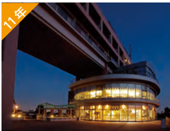
マリントラスあしやオープン
