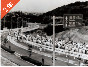
国道3号岡垣バイパス開通
