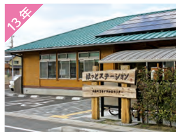
水巻町ほっとステーション新築移転
