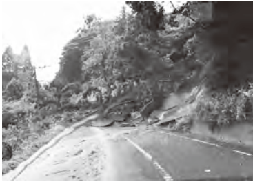
▲岡垣町でも土砂崩れなどが発生
