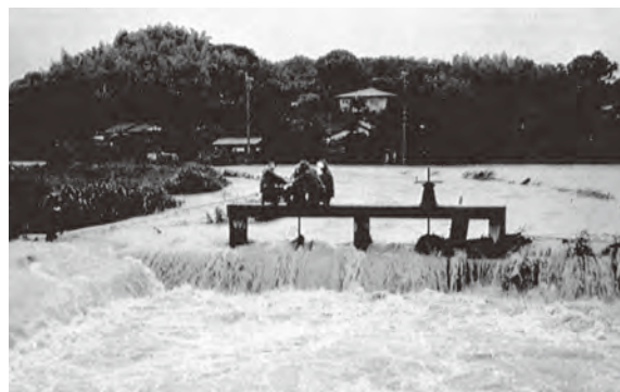
▲はん濫した矢矧川。被害額は12億円を超えた。 昭和 56 年 7 月撮影
