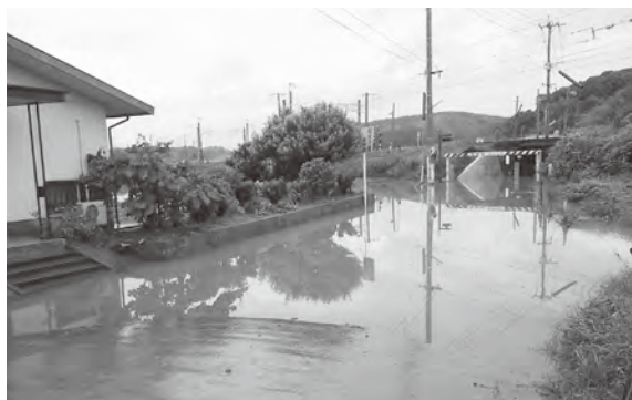
▲戸切区千代丸踏切周辺の冠水 平成 18 年 6 月 23 日撮影
