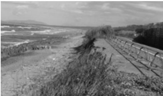
▲隣接する自転車道の一部では、海岸浸食の影響により、斜面が削られ危険な場所も見られる
