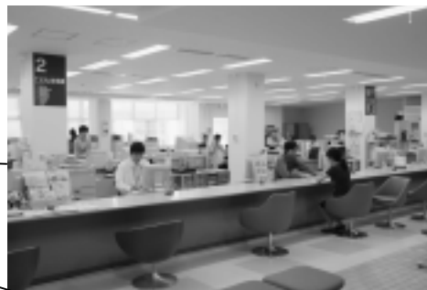
総合窓口設置工事。窓口サービスを中心とする住民課と子ども未来課を本館1階に配置し、ワンストップサービスを推進しました。
