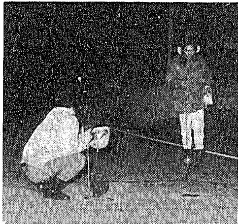
漏水調査……地下の漏水は深夜、騒音のないとき探知器などにより発見します。
