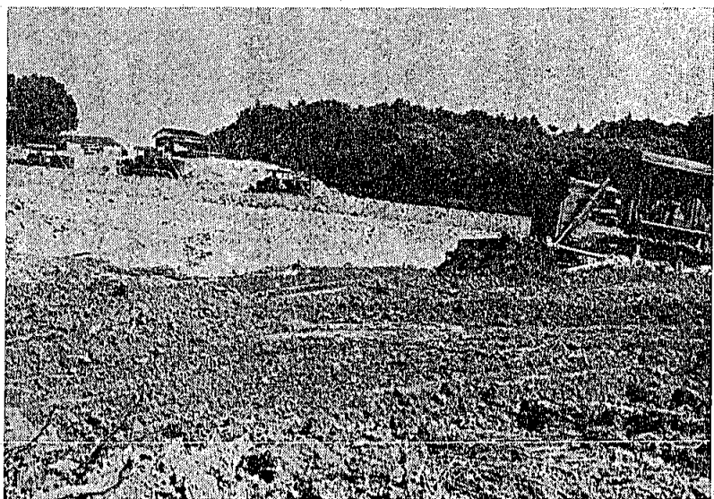
海老津小学校用地造成工事
