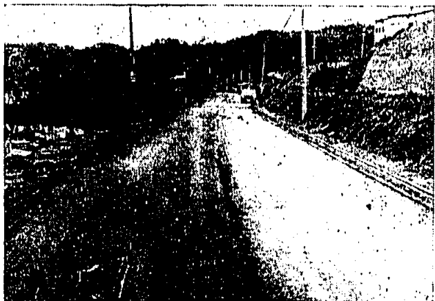
海老津~戸切線舗装工事
