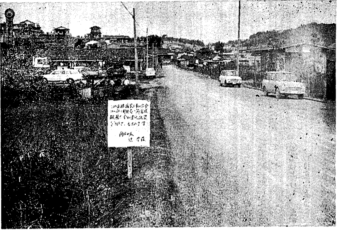
完成した野間～山田線の舗装
