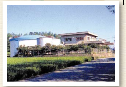
▲昭和58(1983)年 浄水場横貯水池完成
