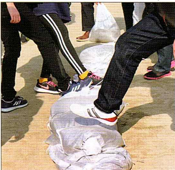
積んだ土のうを踏み固める 土のう袋に土を詰め込む作業
