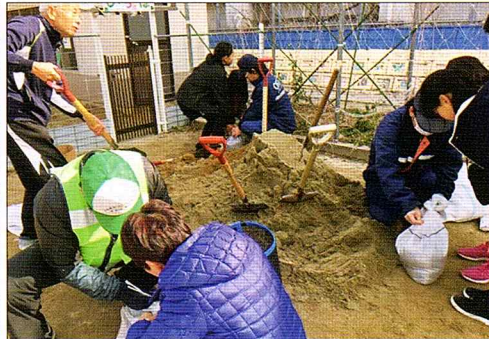
積んだ土のうを踏み固める 土のう袋に土を詰め込む作業
